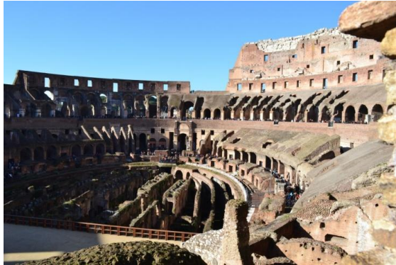
L'intérieur du Colisée
