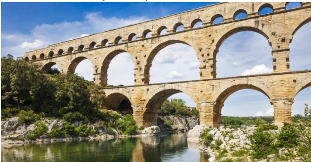
Le Pont du Gard (France)
