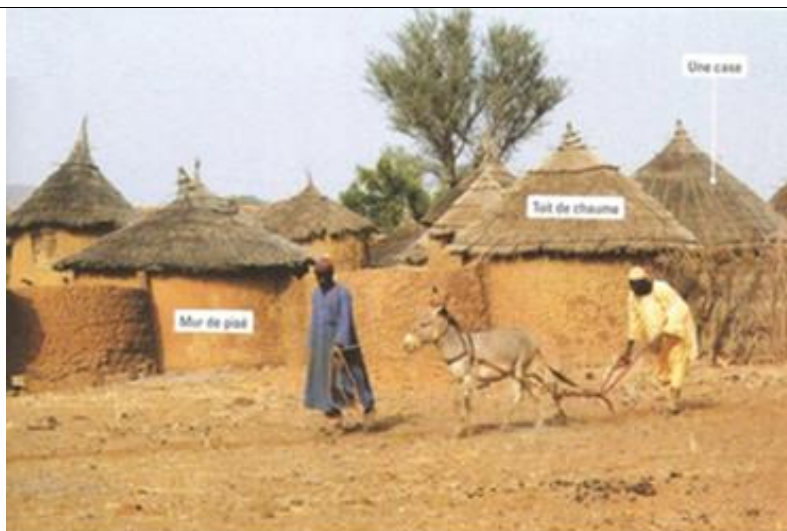
Mur de pisé – Toit de chaume – Une case
