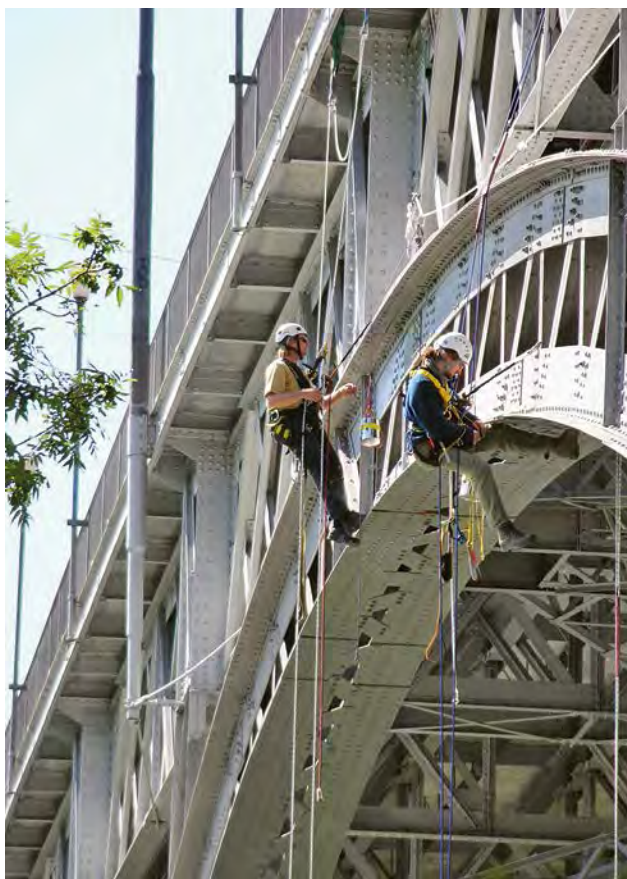
Fig. 2 Lavori in sospensione a corde portanti
